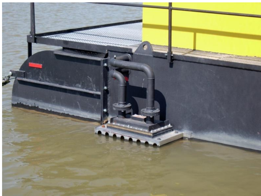
Pływaki ruropociągu tłocznego i kadłuba pogłębiarki.
