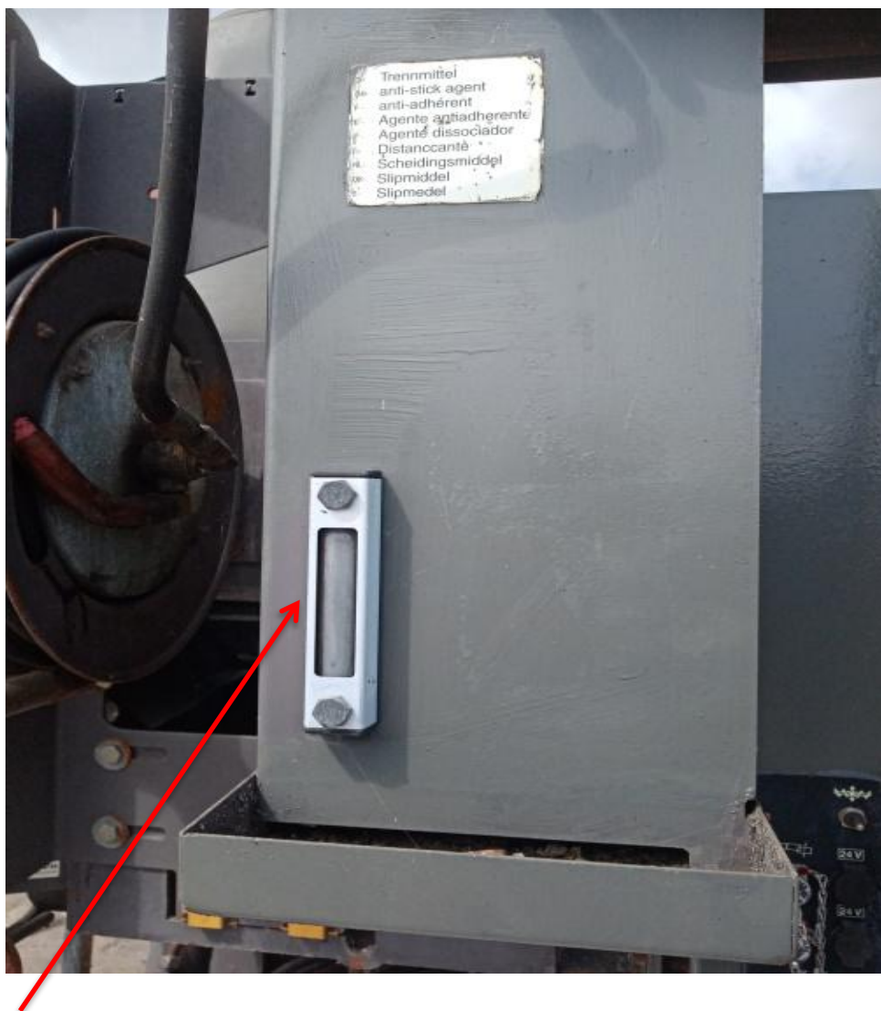
Wskaźnik poziomu oleju umieszczony na zbiorniku.
