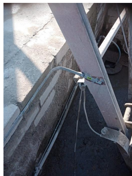
Instalacja uziemiająca wykonana za pomocą bednarki.
