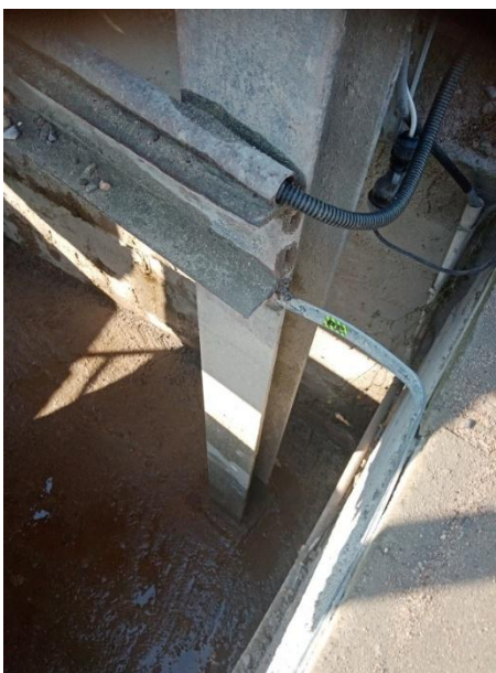
Instalacja uziemiająca wykonana za pomocą bednarki.
