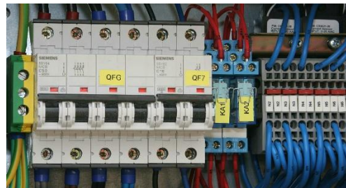
A, B - listwy bezpiecznikowe na pulpicie operatora układarki.
