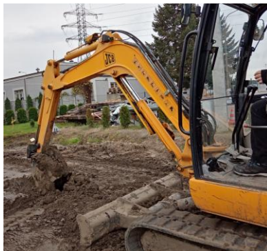
Kolejność ruchów roboczych koparki w trakcie wykonywania wykopu jamistego.
