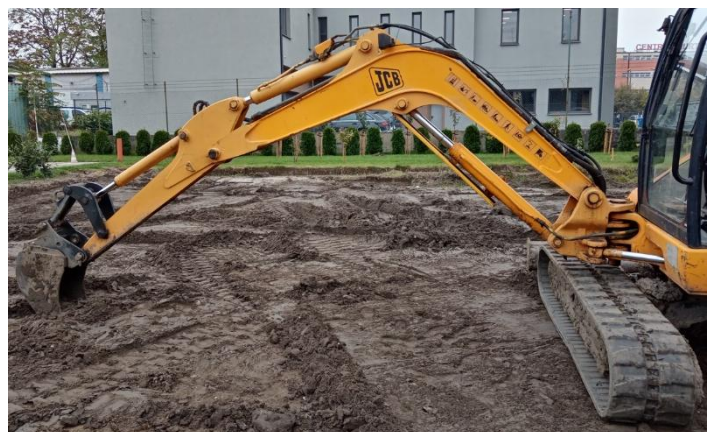
Pozycja maszyny przygotowanej do wykonania wykopu metodą boczną.
