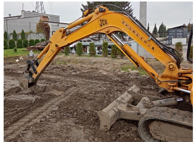
Pozycja maszyny przygotowanej do wykonania wykopu metodą czołową.
