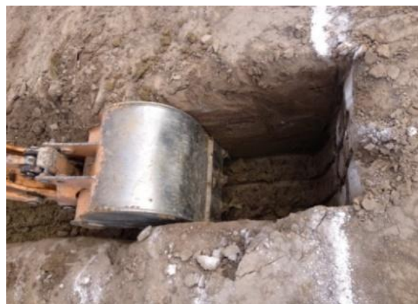
Wykonywanie wykopu wąskoprzestrzennego poniżej posadowienia maszyny.
