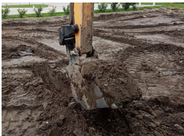
Wykonywanie wykopu wąskoprzestrzennego poniżej posadowienia maszyny.
